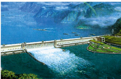
三峡水电开发总公司
